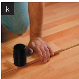
Positionnez la lame en place à l'aide d'un maillet de caoutchouc et d'un bloc de bois.
