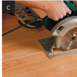
Effectuez une coupe en diagonale au centre de la lame d'une extrémité à l'autre des incisions réalisées à l'étape précédente (plus d'une coupe peut être nécessaire lorsque la lame est collée).
