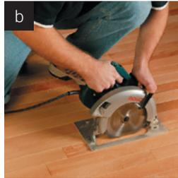
À l'aide d'une scie circulaire ou d'une toupie, couper la lame sur toute sa longueur à environ 1/2" de chaque côté des bordures. Ajustez la profondeur de coupe en fonction de l'épaisseur de la lame. Pour un plancher collé, effectuez plusieurs coupes rapprochées afin de séparer la lamelle en sections réduites.
